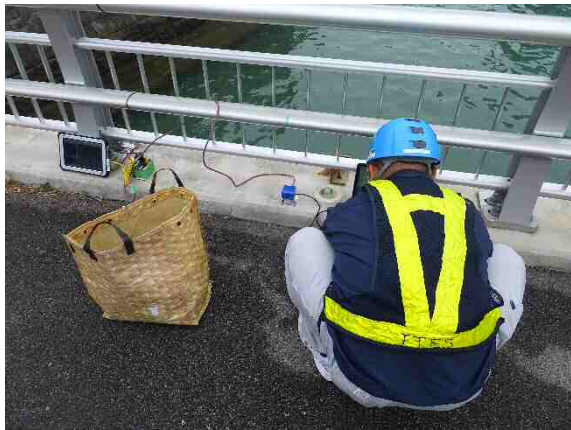
写-2-3 加速度計設置状況
