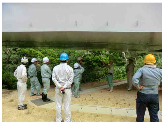
写-1-1 I 橋アルミ遮塩版視察状況
