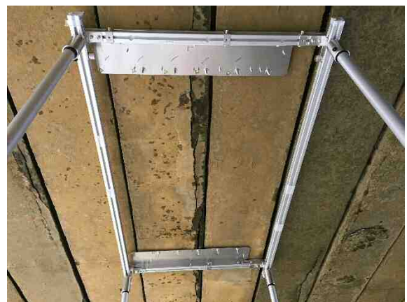
写-3-2 測定フレーム設置状況
