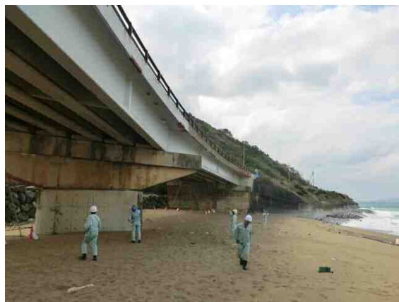
写-1-4 H橋補修箇所再劣化視察状況
