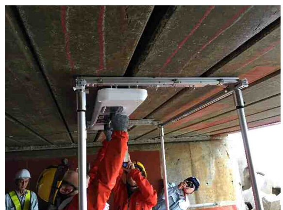
写-3-4 検査機器による測定状況(2)
